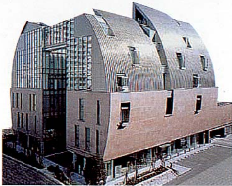
2年前に完成したタイセイ株式会社本社。中央区清川にあり、1階には『ガラド オウ』が入る。建物は地球の丸さをイメージしたものだとか
